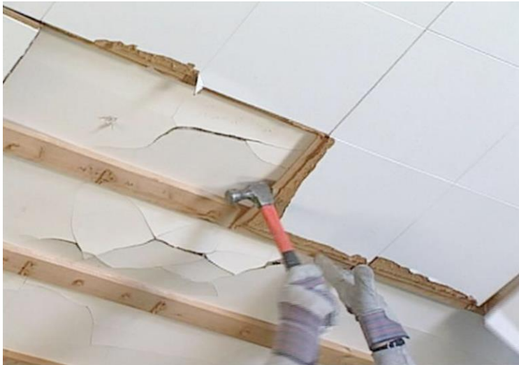
ការប្តូរទ្រង់ទ្រាយផ្ទៃកខាងក្នុង នៃសំណង់ ដូចជាបង្គោលដៃសុវត្ថិភាព ពិតានដែលមិនធ្វើពីបេតុងដែក ជញ្ជាំងខណ្ឌបន្ទប់ដែលមិនទ្របន្តក
